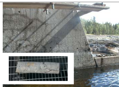
Vänster: Dammpelare med sprickor orsakade av alkaliskesyra-reaktion (akr). Sprickorna syns på den utborrade kärnan. Mitten: bropelare med akr-sprickor. Höger: Nygjuten broplatta med plastiska krympsprickor. Dessa konstruktioner undersöktes med seismiska provningsmetoder.
