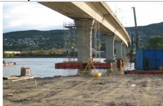
Vänster: Bro med efterspänd betong. Innan borring i balksidorna skall spännkablarnas lägen kartläggas med röntgen. Mitten: röntgenplåten monteras på utsidan. Höger: isotopen monterad på insidan.
