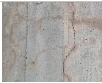
Vänster: Dammpelare med sprickor orsakade av alkaliskesyra-reaktion (akr). Sprickorna syns på den utborrade kärnan. Mitten: bropelare med akr-sprickor. Höger: Nygjuten broplatta med plastiska krympsprickor. Dessa konstruktioner undersöktes med seismiska provningsmetoder.
