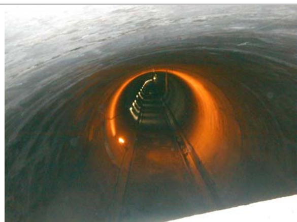
Vänster: Denna tunnel har en 600 mm tjock betongmantel som platsgjutits. Höger: Betongens tjocklek och homogenitet kontrolleras med ultraljudmätning.
