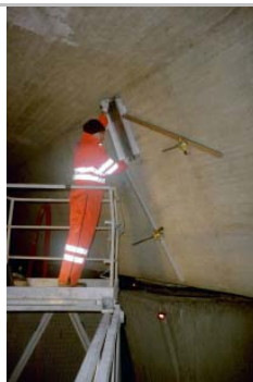
Vänster: Bro med efterspänd betong. Innan borring i balksidorna skall spännkablarnas lägen kartläggas med röntgen. Mitten: röntgenplåten monteras på utsidan. Höger: isotopen monterad på insidan.
